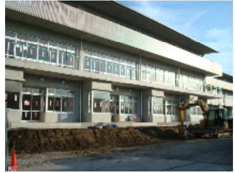
<覆いが取り外された南側校舎>
