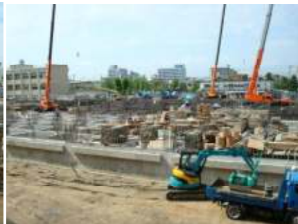
(6/23 取り外された型枠)
