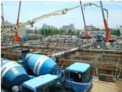
(6/17 コンクリート注入)
