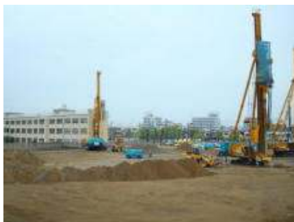
(5月1日地盤改良工事)
