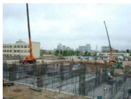
(5月29日鉄筋組み立て)
