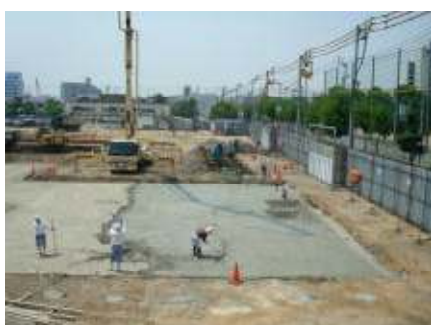
(5月23日コンクリート打ち開始)
